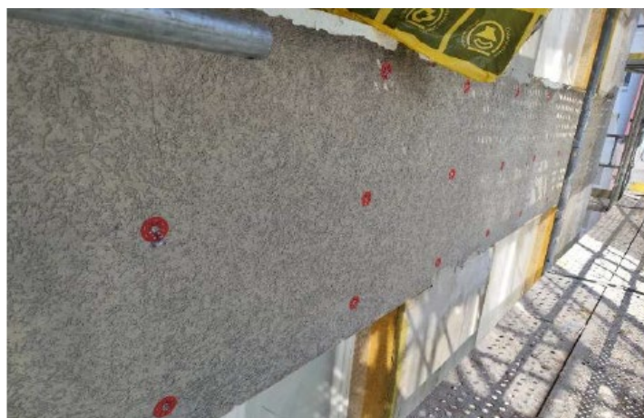
Obr. Raster 0,75 x 0,75 m kotvenia kotvy SXRL-T na pôvodnom zateplení.
