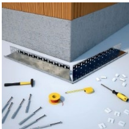
Obr. Osadenie rohového profilu v rohu budovy. Osadenie okapničky na soklový profil.
