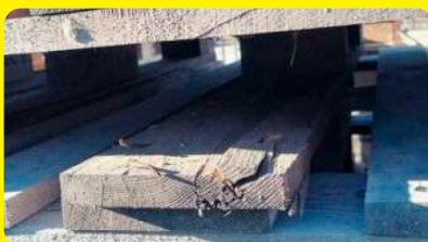
Zle upevnená doska a uvoľnený klinec
