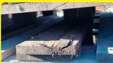
Zle upevnená doska a uvoľnený klinec
