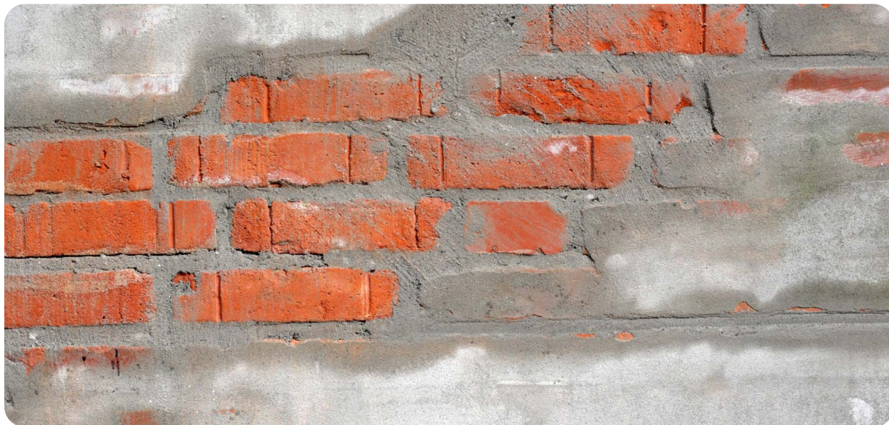
Podklad zaťažený vlhkosťou
