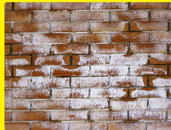
Príklad muriva zaťaženého soľami
