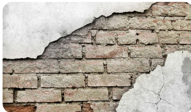
Podklad zaťažovaný vlhkosťou
