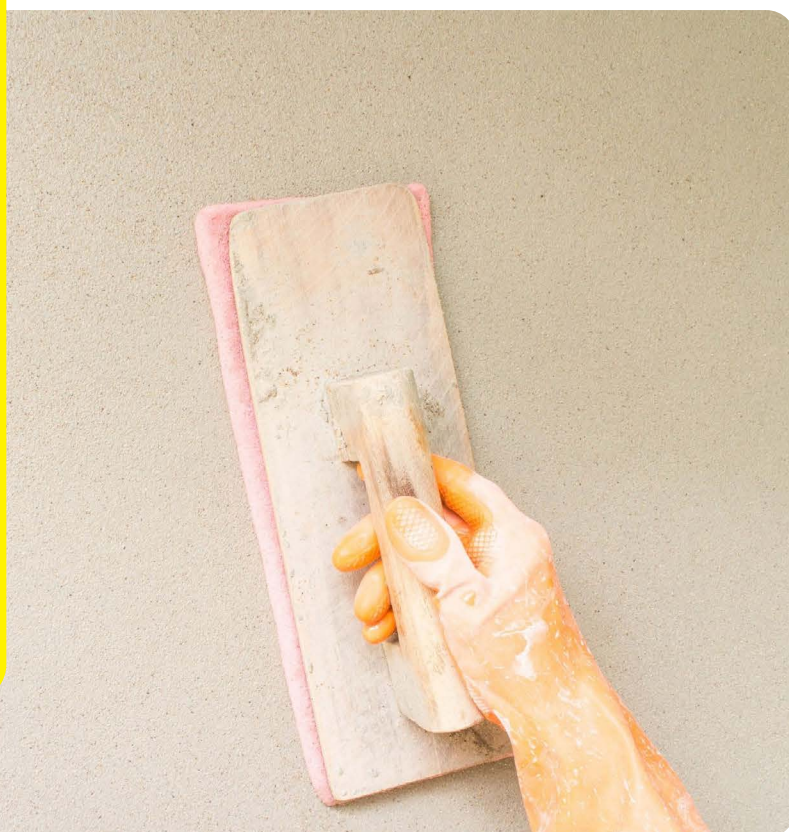
Aplikácia sanačnej štukovej omietky
