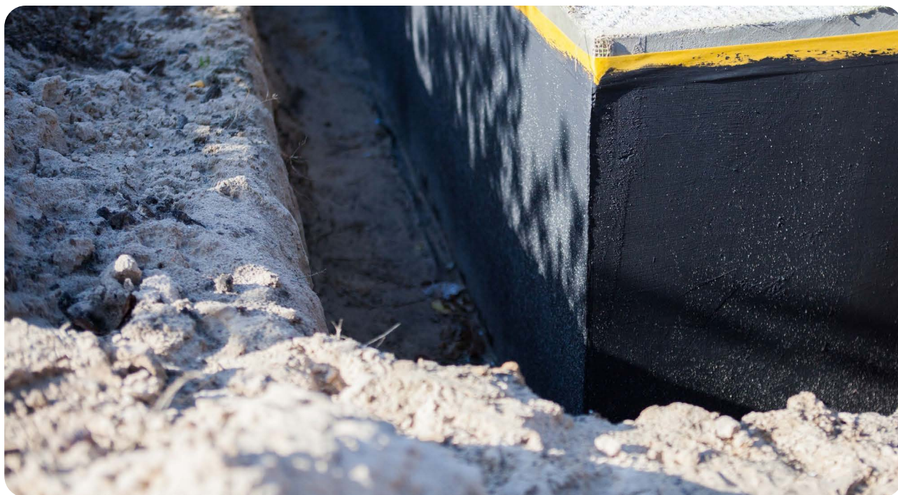
Aplikácia hydroizolačnej stierky
