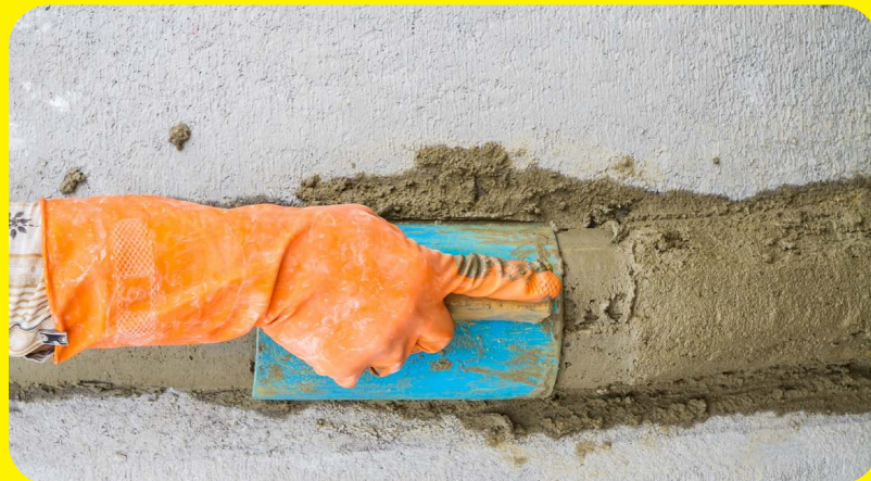
Aplikácia vysprávkovej malty
