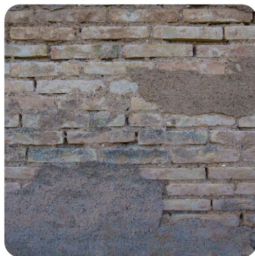
Ukážka podkladu pred aplikáciou
