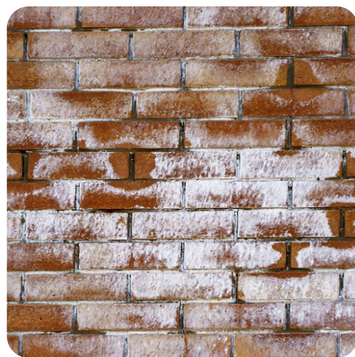
Príklad muriva zaťaženého soľami
