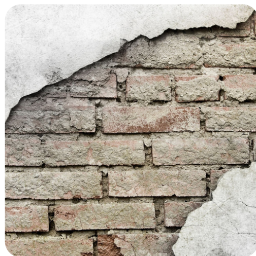
Podklad zatažený vlhkosťou
