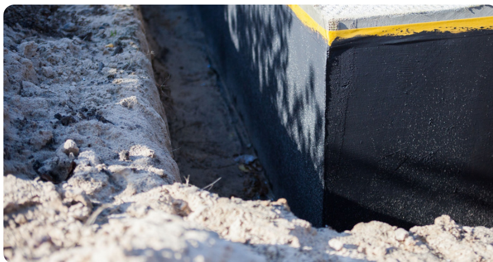
Aplikácia hydroizolačnej stierky
