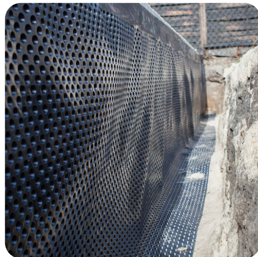
Vloženie nopovej fólie
