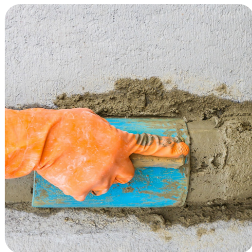
Aplikácia vysprávkovej malty
