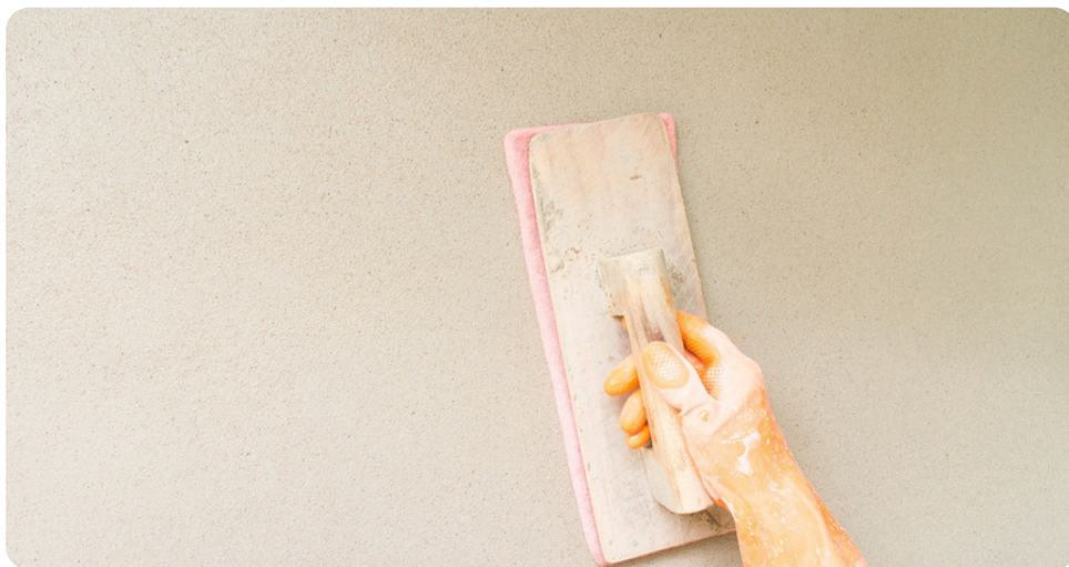
Aplikácia sanačnej štukovej omietky
