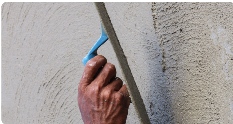
Finálna povrchová úprava
