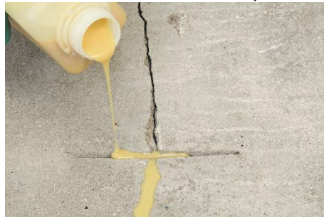
Obr.č.3: Vyplnenie škár weber.floor Blitzhartz easy
