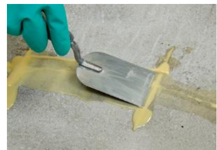
Obr.č.6: Zahľadenie povrchu a posyp s kremičitným pieskom
